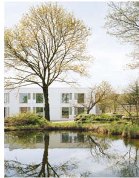
1 Ostfassade mit vorgelagertem Teich
