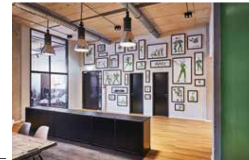
Bilder und Grafiken als Akustikelemente, Decke mit offener Kabelführung –
