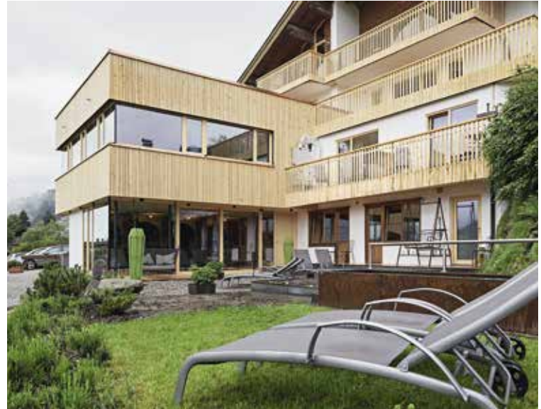
Außenansicht: Holzanbau an Stammhaus
