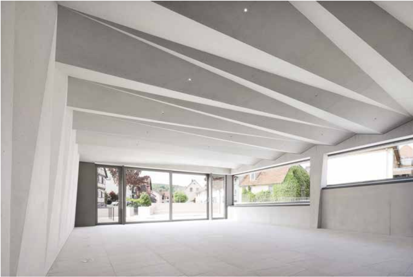
| Innenansicht mit Ausblick auf Terrassierung und Außenanlage
