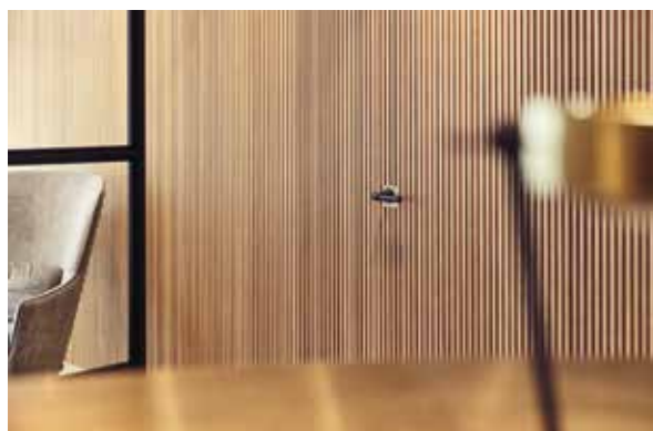
Detail Wandverkleidung Holz
